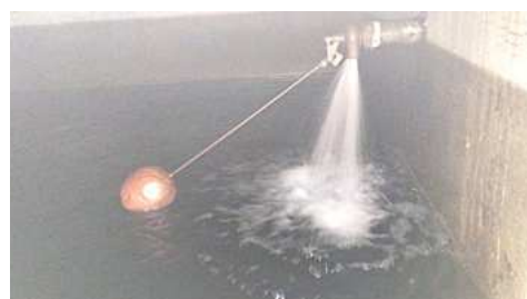
Sector La Providencia Baja: Cloración del tanque de almacenamiento de agua potable.
