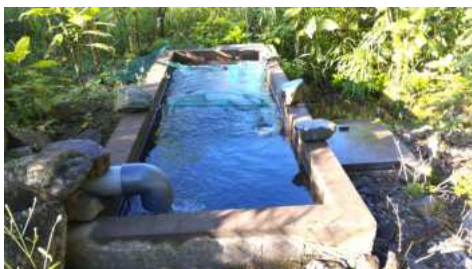
Red La Pinta: Limpieza del sistema de captación de agua.
