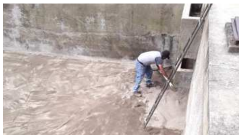
Parroquia El Corazón: Lavado de arena, limpieza de filtros y cloración en la red de agua potable.
