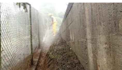
Parroquia Moraspungo, sector San Alberto: Limpieza integral de los tanques de aguas residuales.
