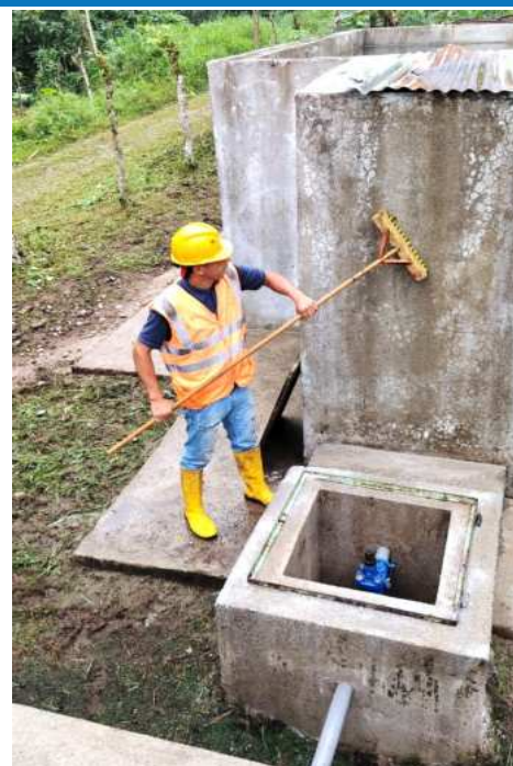
Red La Mariela – Guapara Ejecución de labores de mantenimiento similares, incluyendo lavado de arena, filtros y cloración.
